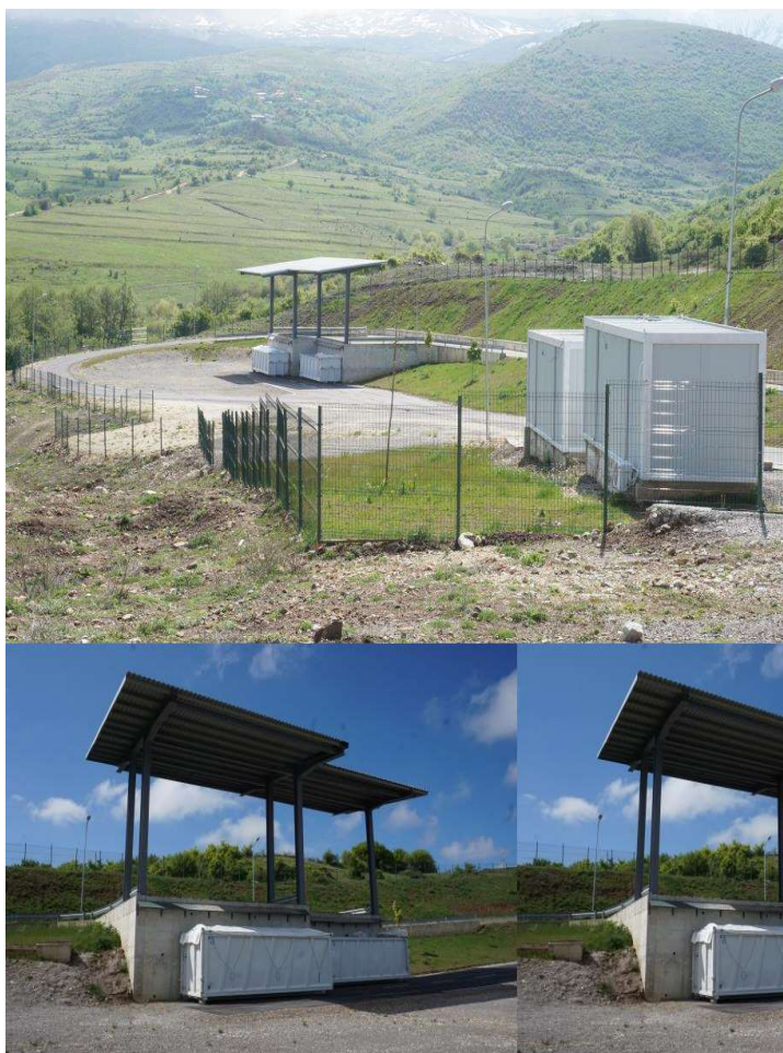
Figura 21 Stacion transferimi me rampë në Ersekë, Qarku Korçë
